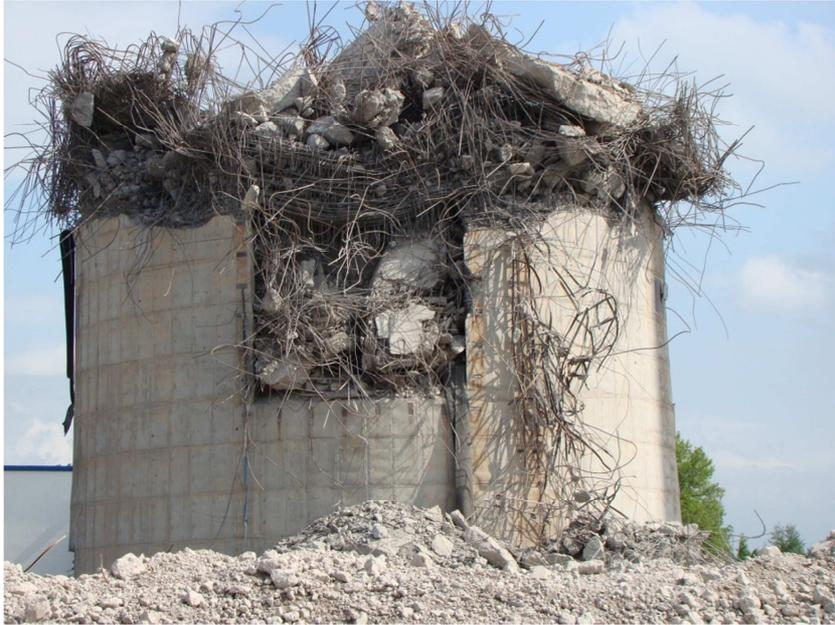
Bild 4- 2: Rest eines rückgebauten Stahlbetonschonsteins mit zerkleinertem Beton und verformtem Bewehrungsstahl
